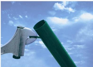
3.- **Colocar los tornapuntas** por la parte exterior de su abrazadera y a una distancia de 20 cm de la cabeza del poste. Los tornillos deben orientarse hacia el interior del cercado para que no interfieran al colocar las pletinas de arranque.
