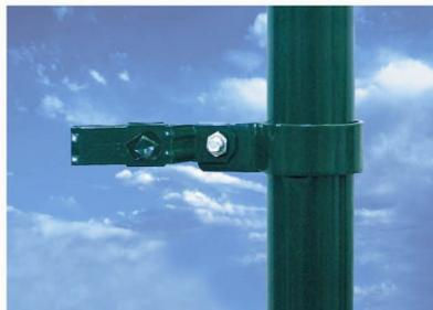
7.- **Enganchar los alambres** en los tensores, procediendo a su tensado.
