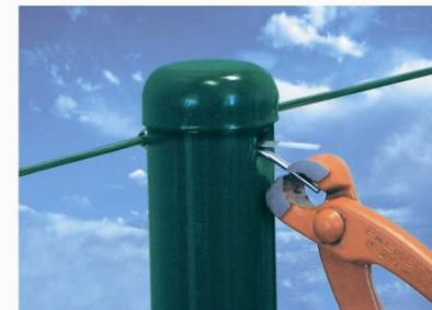
9.- **Colocar la malla**, introduciendo la pletina de arranque por un extremo. Sujetar la pletina sobre los mismos tornillos de las abrazaderas, tensarla y repetir el proceso en el otro extremo.
