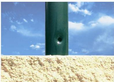
5.- **Es aconsejable colocar un tornillo** o remache en las abrazaderas de los tornapuntas de arranque y esquina para evitar el deslizamiento de los mismos por el poste al tensar el alambre.
